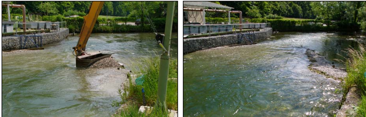
Abbildung 2 Geschiebe (gesamt 75 t) wird per Bagger zugegeben. Buhnen aus Totholz und Kies sind hier notwendig, um die geforderten Strömungsgeschwindigkeiten zu erzeugen.
