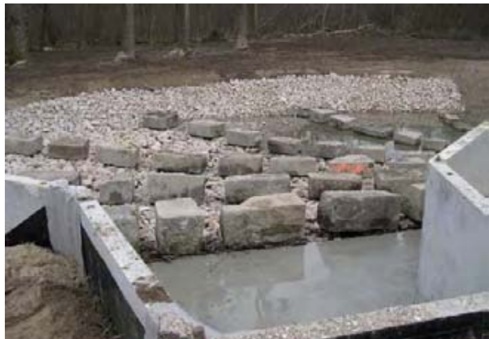
Abb. 1: Verunglückter Fischpass an einem Rheinabzweig im Elsass (F)
