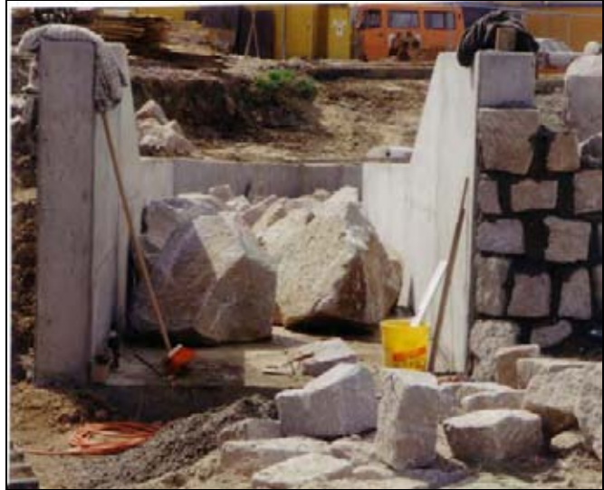
Abb. 24: Direkt auf die Betonsohle gelegte Pyramidenblöcke
