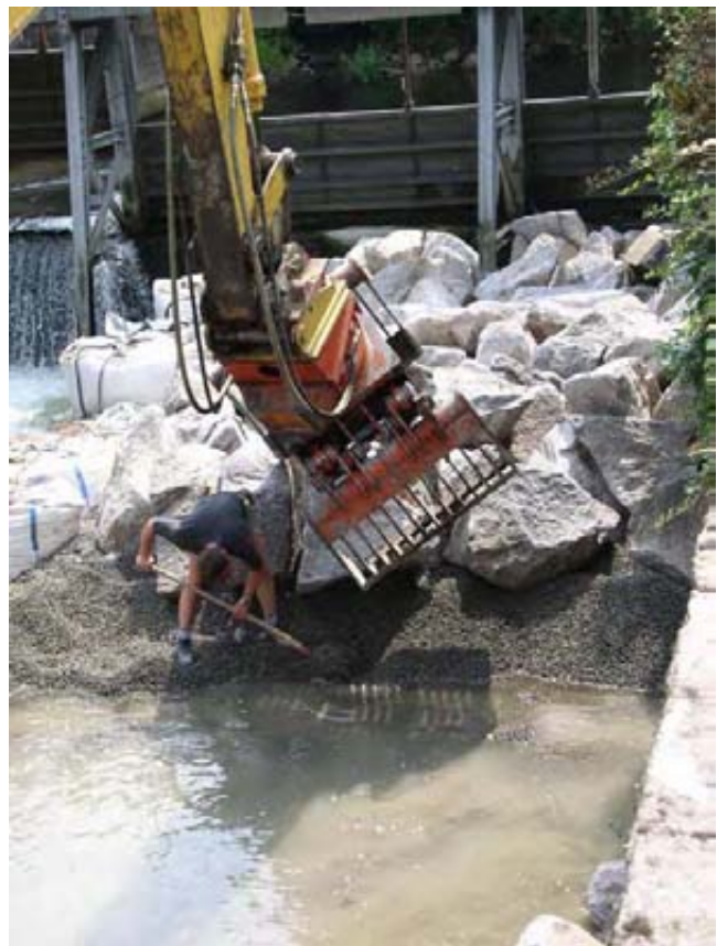
Abb. 13: Halbseitig mit einem Fangedamm abgetrennter Gewässerabschnitt, Alb in Ettlingen, BW
