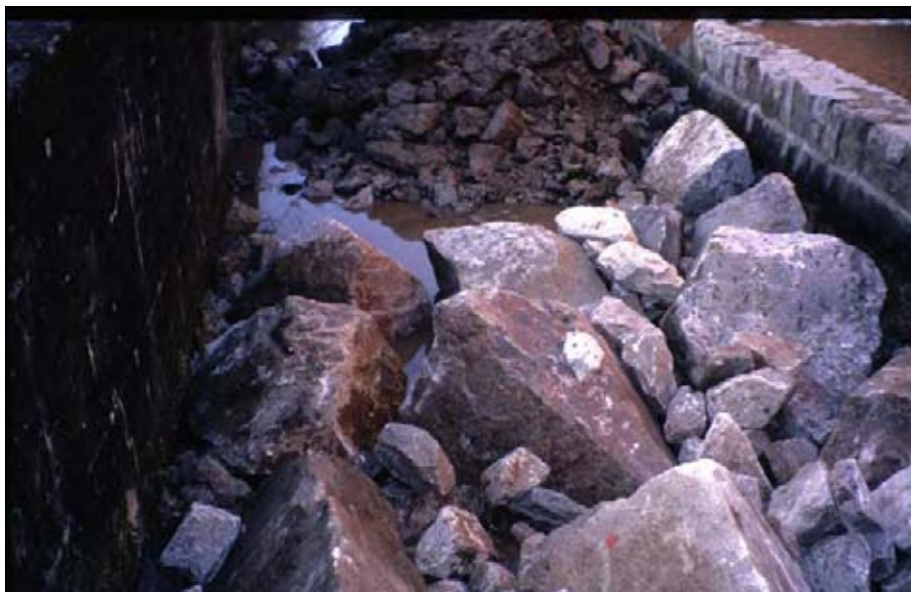
Abb. 29: Einbringen von kantigem Sohlsubstrat als Sicherungselement
