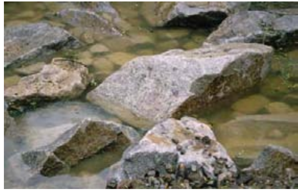
Abb. 21: frisch gesetzter Block mit langer Fläche gegen die Fließrichtung
