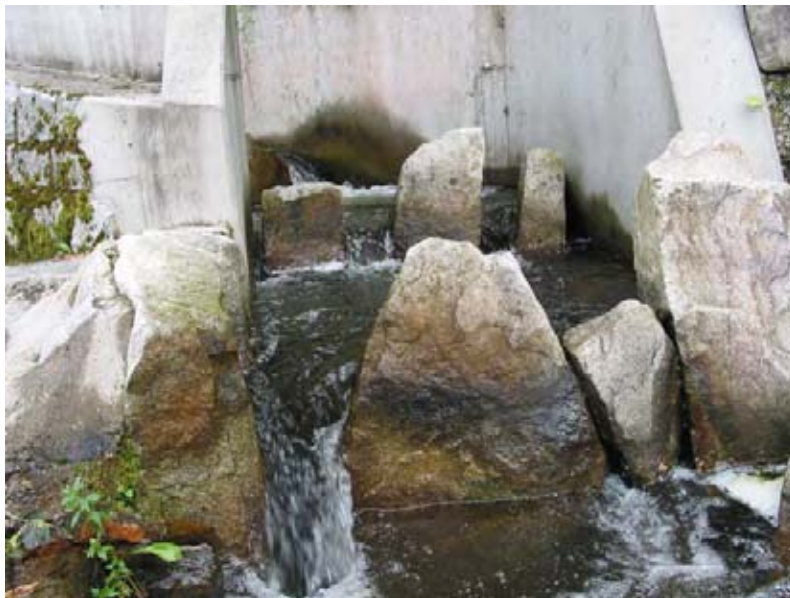
Abb. 9: Riegelbauweise: Ungünstige Blockformen sind anfällig für Verlegung und Ausbildung von Abstürzen
