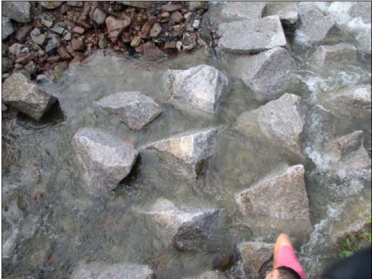
Abb. 6: Dichte Packung an pyramidenförmigen Steinen im Versatz bei halber Dotation
