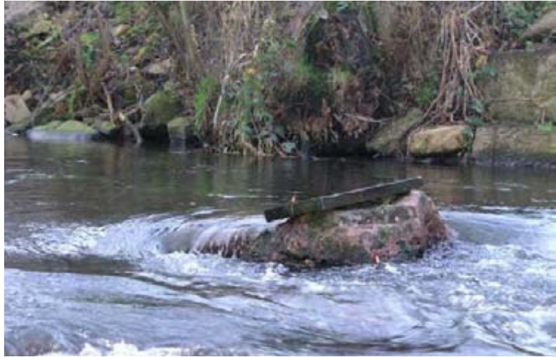
Abb. 8: Aufschieben von Getreibsel und Unrat auf flach geneigte Pyramidenblöcke: kein Verlegen der Durchströmöffnungen
