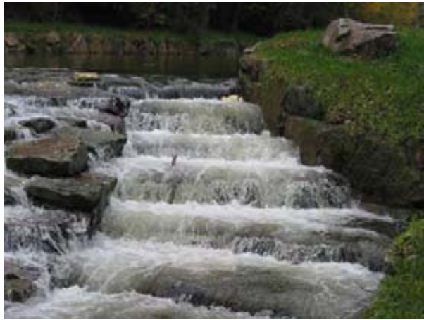
Abb. 2: Verunglückter Fischpass an der Oos (BW)
