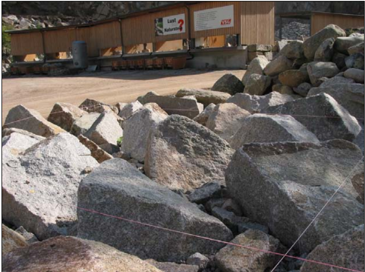
Abb. 14: Im Steinbruch trocken gesetztes Muster eines Raugerinnes (Murgtal, BW)
