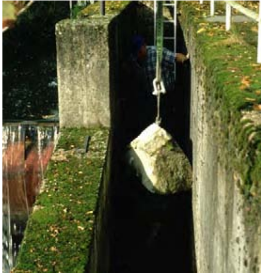
Abb. 26: Einbringen von Blöcken mit Hilfe von Schwerlastdübeln
