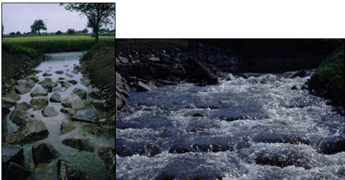
Abb. 31: Mit Blöcken ausgelegtes Gerinne (Foto links; ohne Dotation von Oberwasser in Fließrichtung) und gleiches Gerinne mit Dotation (Foto rechts, von Unterwasser gegen Fließrichtung)
