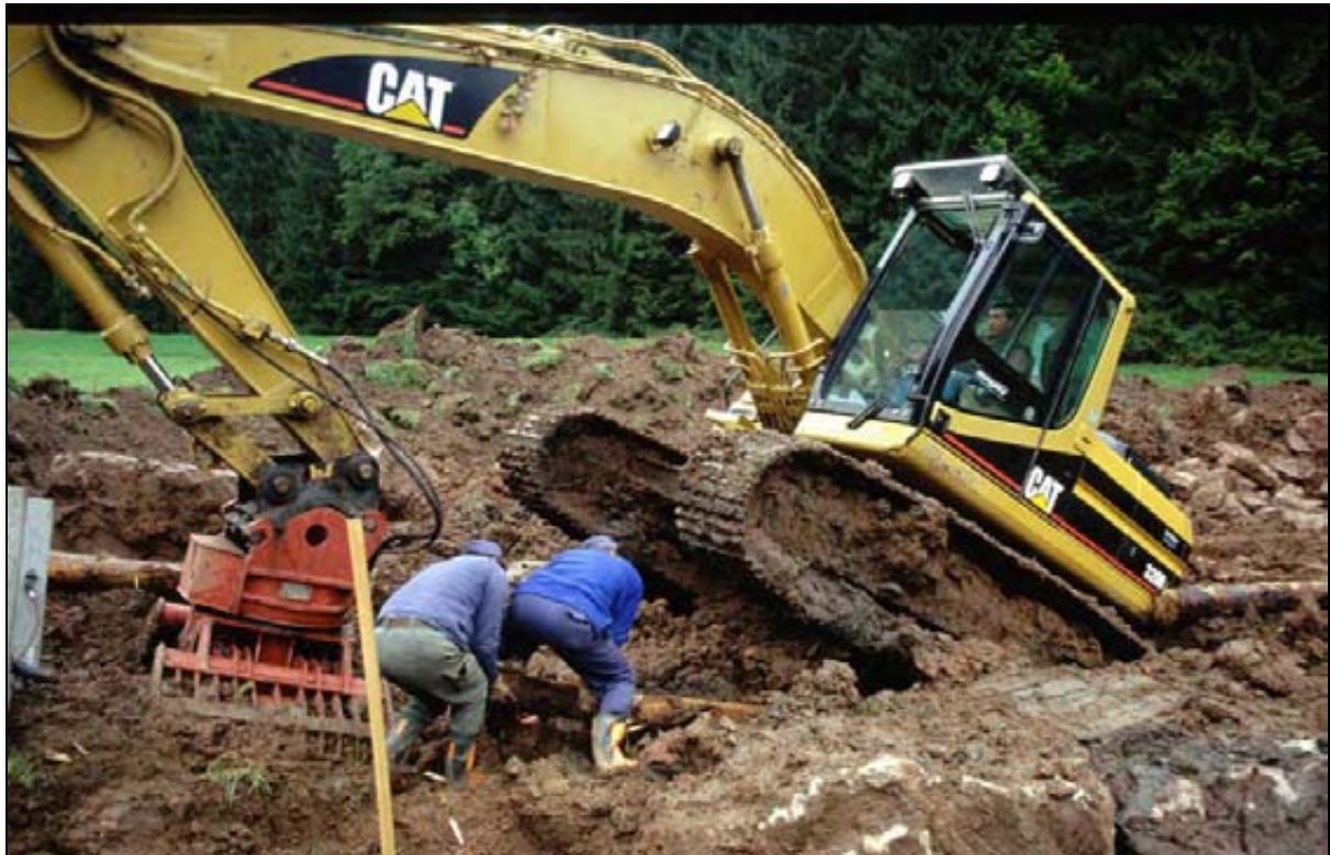
Abb. 15: Der Fischpassbau in schwierigem Gelände erfordert vom Baggerführer Geschick und Fingerspitzengefühl
