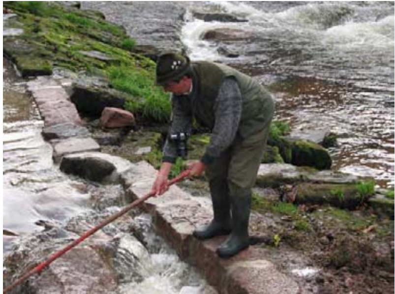
Abb. 30: Probeflutung - Einstellen der Schlüsselsteine
