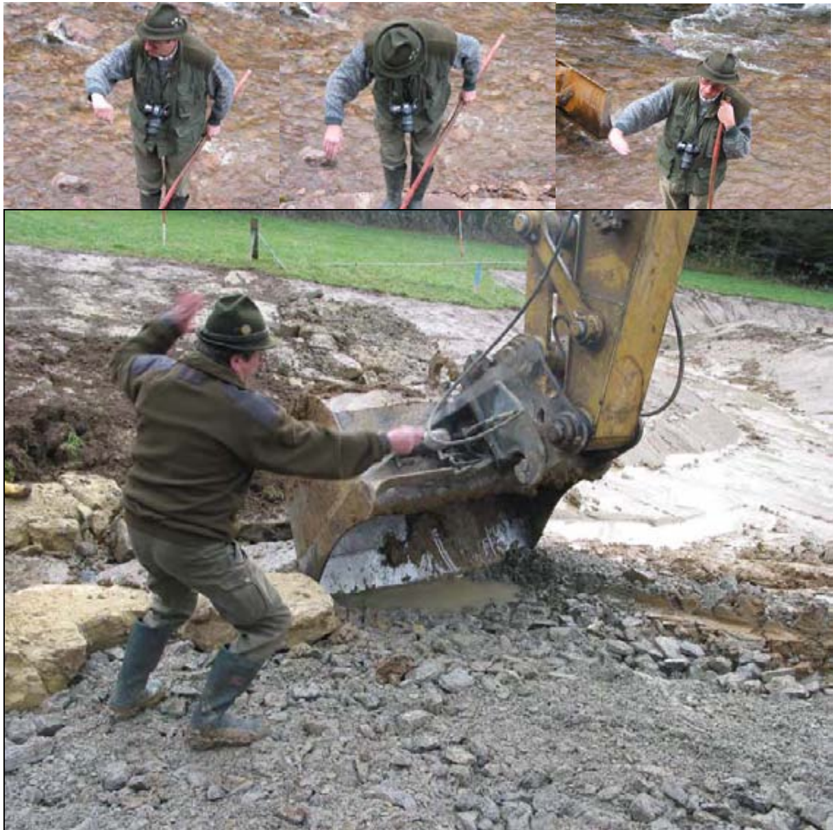
Abb. 16: Klare Kommunikation zwischen ökologischer Baubegleitung und Baggerführer
