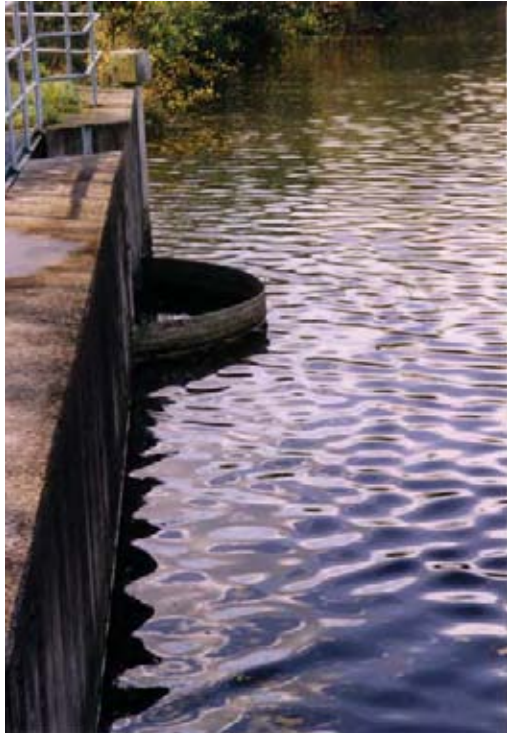
Abb. 33: Einfache Tauchwand als funktionsfähiger Einlaufschutz
