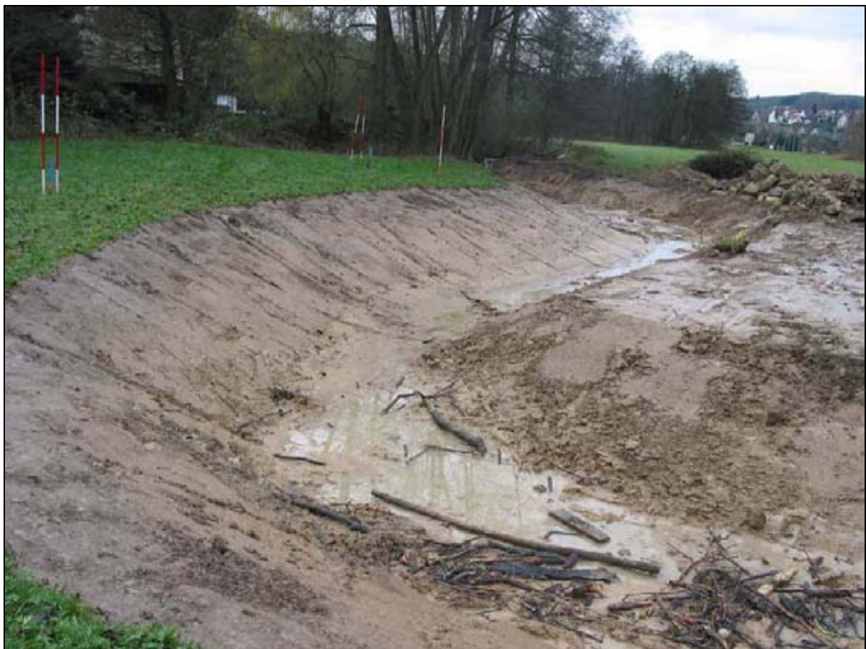
Abb. 17: Für den Blocksatz vorbereitetes Gerinne mit gleichmäßigem Gefälle
