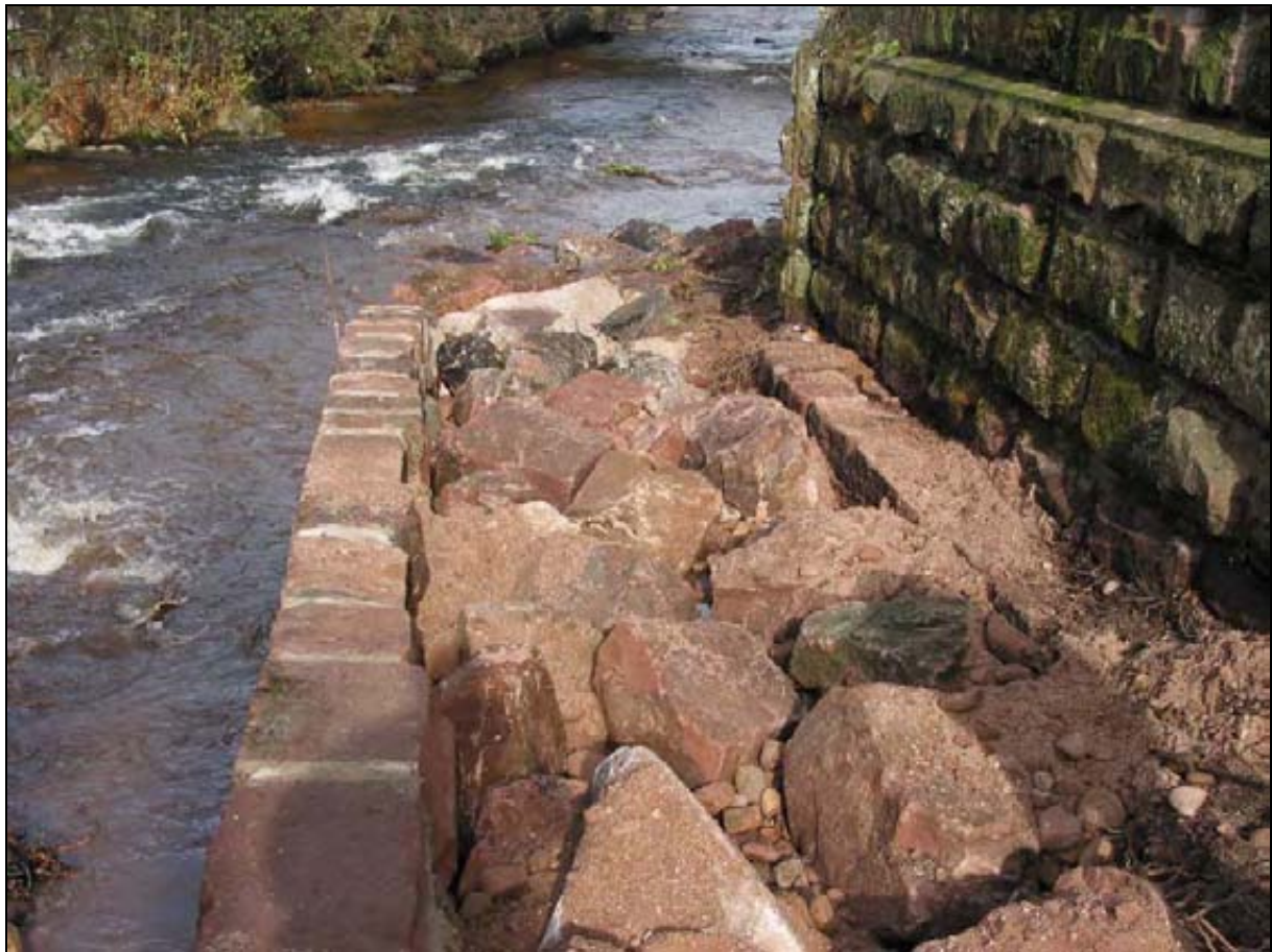
Abb. 18: Eine neue Schwerlastmauer begrenzt linksseitig das Gerinne in der Forellenregion
