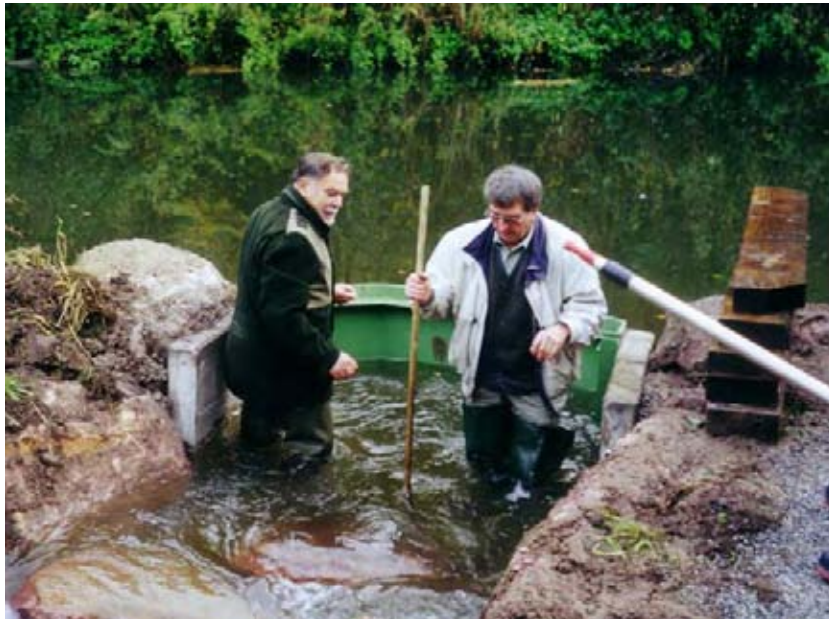
Abb. 11: Günstiger Fischpasseinlauf mit Geschwemmselabweiser (Tauchwand)
